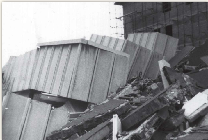
Condominio di Maiano caduto per le scosse di settembre. Foto F.M. Dalla Vecchia.
